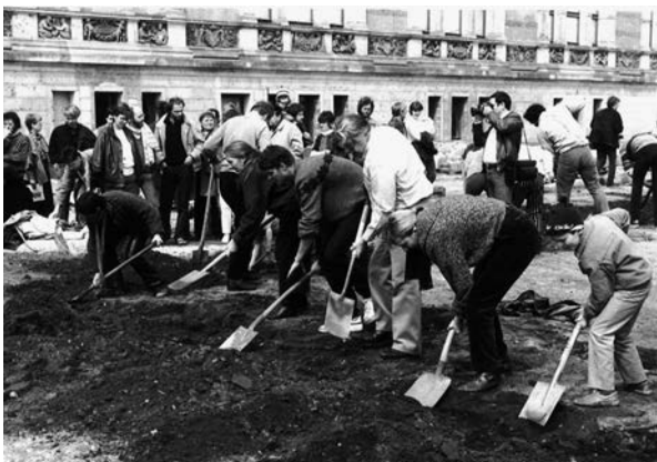
Symbolische Aktion „Nachgegraben 1933-1945“ des Aktiven Museums und der Berliner Geschichtswerkstatt auf dem Gestapo-Gelände neben dem Martin-Gropius-Bau am 5. Mai 1985
