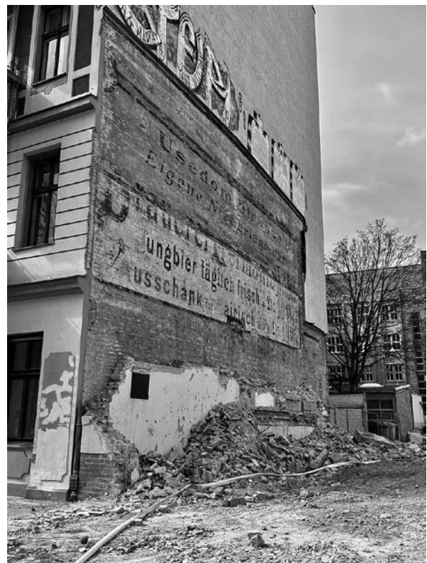
„Gleichzeitigkeit durch Wegnahme“. Abriss eines Hauses in der Usedomer Straße in Berlin Wedding, 2024
